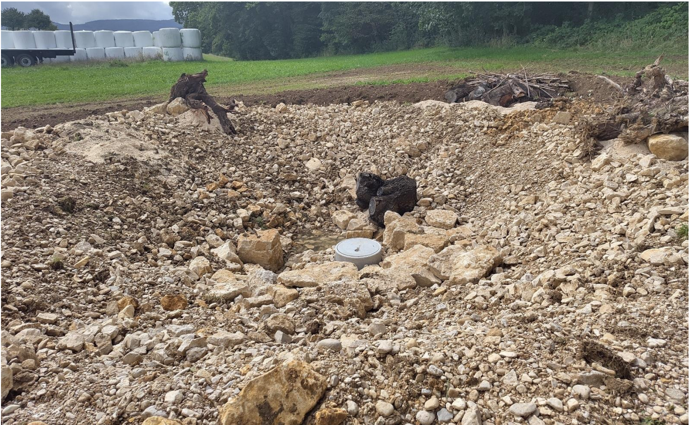
Der Weiher nach Beendigung der Bauarbeiten. Er füllt sich bereits mit Niederschlagswasser.
